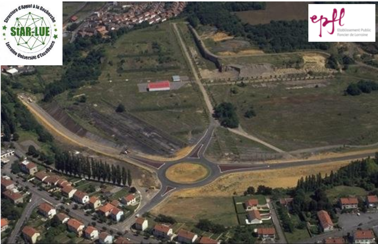
Site de l'ancienne cokerie de Homécourt (5 ha)
